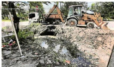
■许多水灾黑区的主要沟渠，都已经清理，包括挖掘烂泥。
